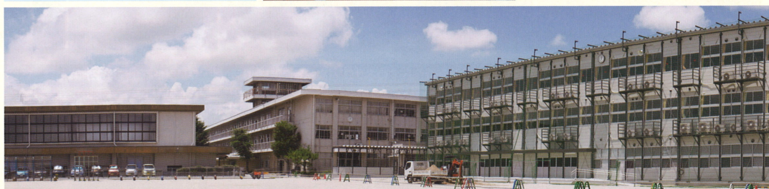
解体直前の校舎と仮設校舎。平成30年7月10日撮影
