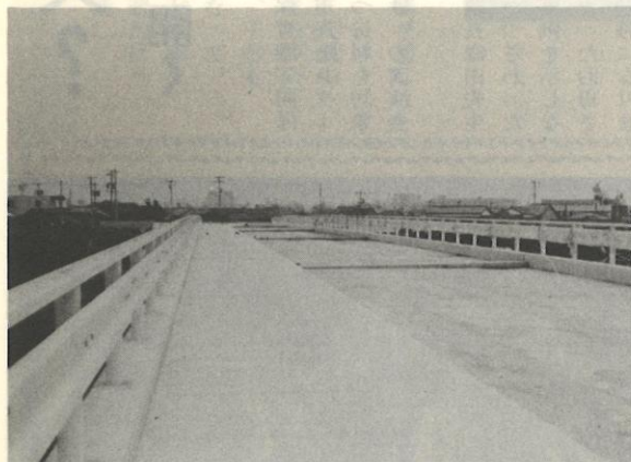
完成間近かな末広橋
