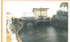
野田川流末の排水ポンプ場
