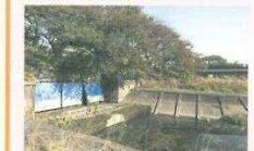
堀川流末の樋門
