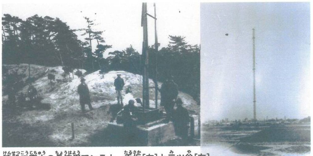
建設工事中の長波用アンテナ 垂坂[左]と三ツ谷[右]
