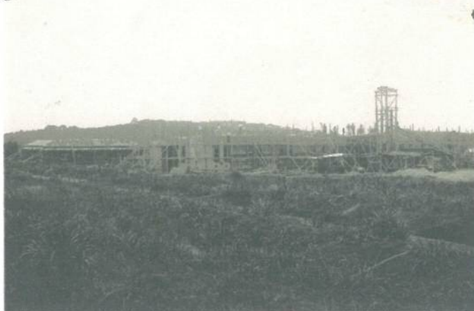
日本無線電信株式会社海蔵受信所の建設工事中の写真（大林組提供）
