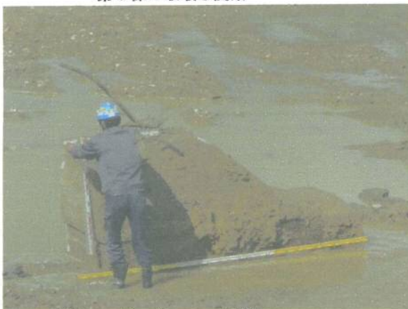
地中から掘り出された巨大なアンカー
