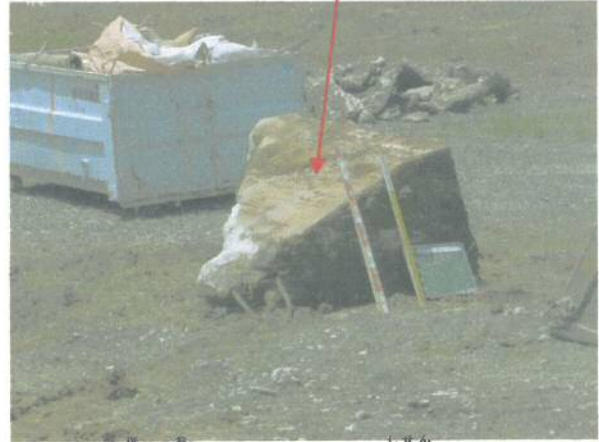
掘り起こされたアンテナ支線アンカー
