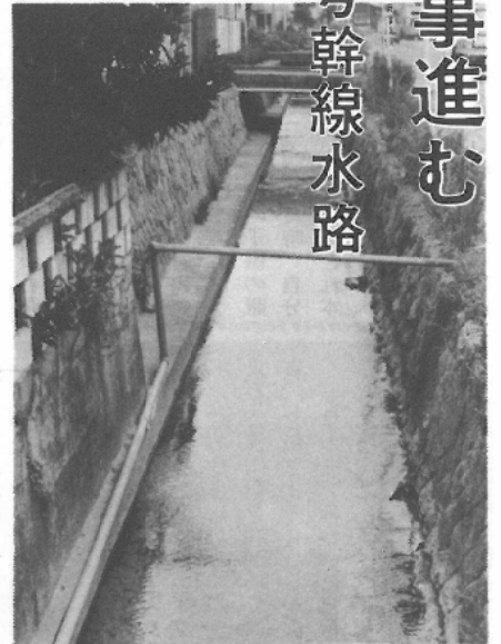
羽津2号幹線水路(アラキヤ南)
