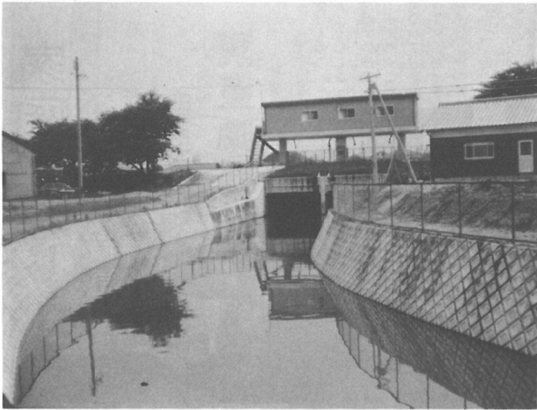
(改修の終わった部分の)源の堀川と樋門
