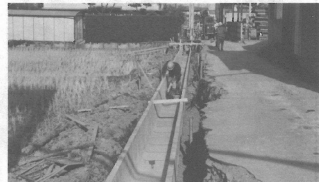
三ッ谷地内の工事現場
