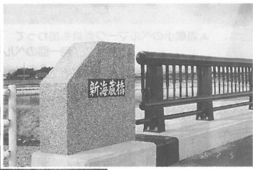
菰野町川北・下村間の新海蔵橋
