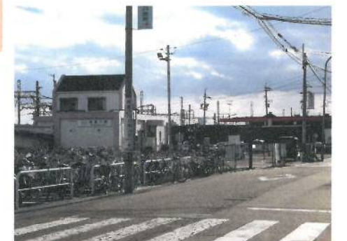
整備が望まれる阿倉川駅付近
