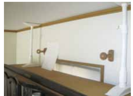
突っ張り棒による家具の固定
