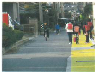
【西阿倉川浄覚寺南側市道】 市道阿倉川西富田線からの道路沿い水路600mの暗渠化を平成21年度から進め、本年度85mを実施し325mが完成しました。
