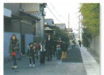
【清水町地内の市道】 国道365号から海蔵川堤防下までの道路側溝170mの蓋設置等整備を平成23年度から実施。本年度17mを整備。完了しました。
