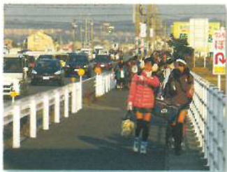
【市道赤堀山城線の北側歩道】 海蔵地区市民センターから海蔵保育園までの間、農地側にガードパイプ(平成23年度)、車道側にガードレール(本年度)が設置されました。
