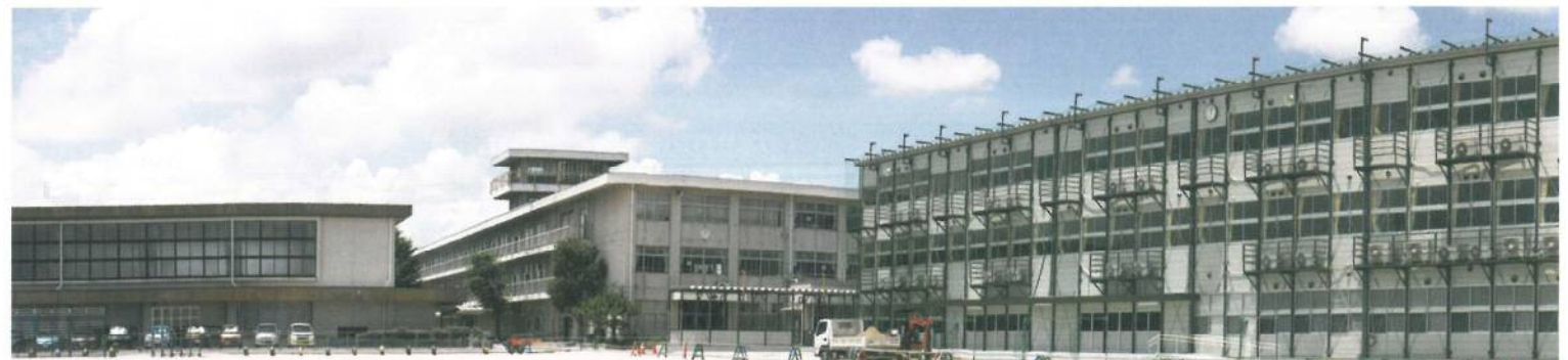
解体直前の校舎と仮設校舎。平成30年7月10日撮影
