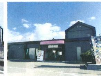
整備前の駅前広場
