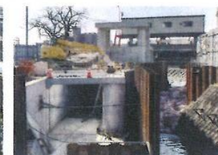
堀川排水機場
