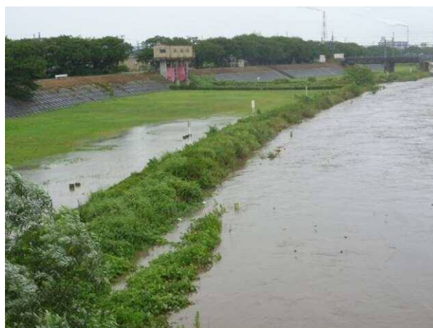
増水時の海蔵川末広橋下流左岸
