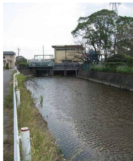
増水時に三滝川新川へ排水する野田川排水機場
