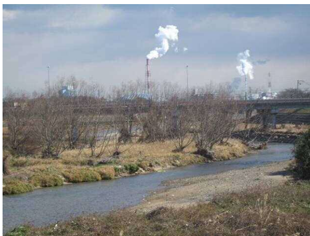
雑木が繁茂する海蔵川末広橋上流
