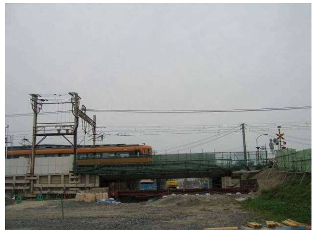
三滝川鉄橋北詰で進む立体交差工事
