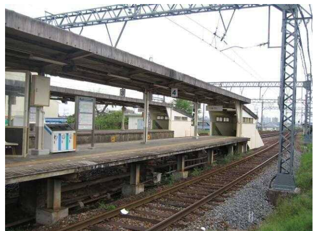
地下通路と階段で結ぶ阿倉川駅プラットフォーム
