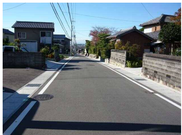
電柱が片側に設置された松が丘の東沿いの市道
