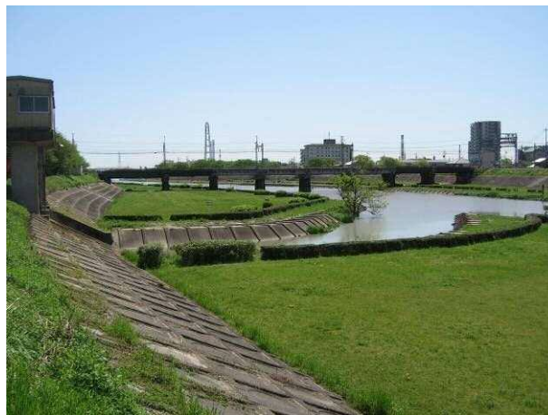
堀川の樋門水路が横切る海蔵川緑地
