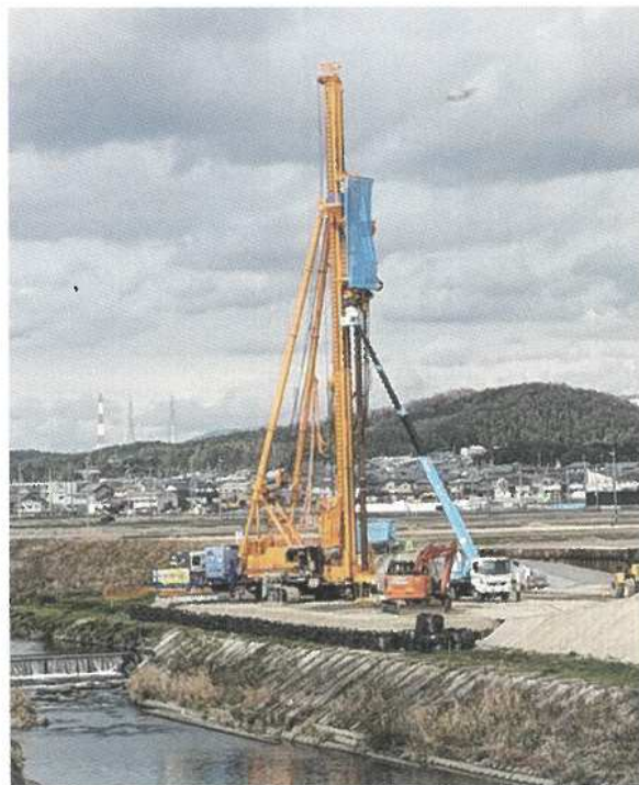
西阿倉川樋門設置工事の様子
