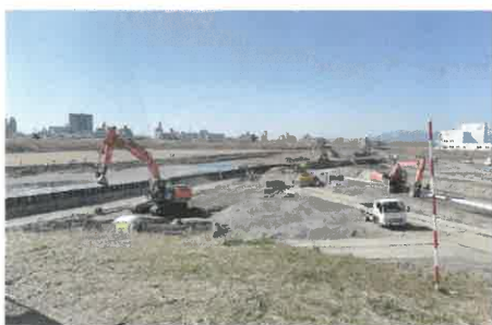
末永町地先導流堤・低低水護岸等工事
