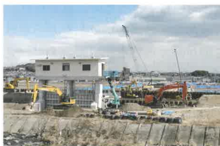
西阿倉川樋門と堀川放水路整備工事
