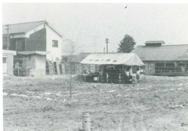
管理棟の地鎮祭
