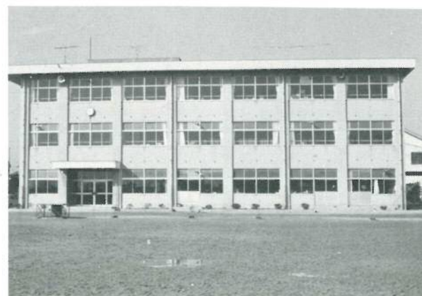
完成した管理棟
