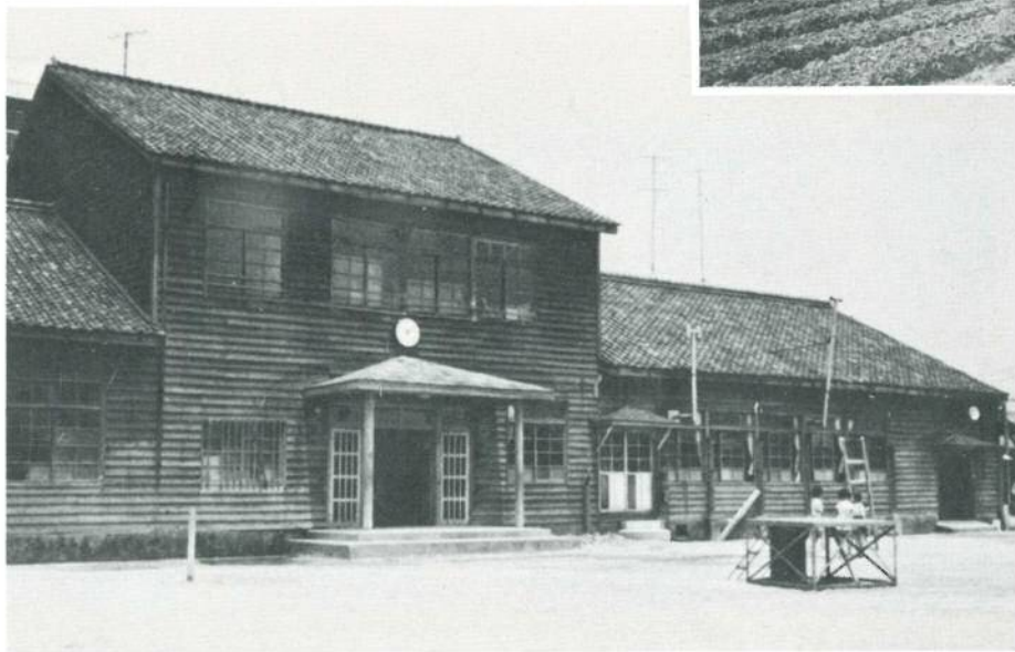
昭和23年に新築された本校舎
